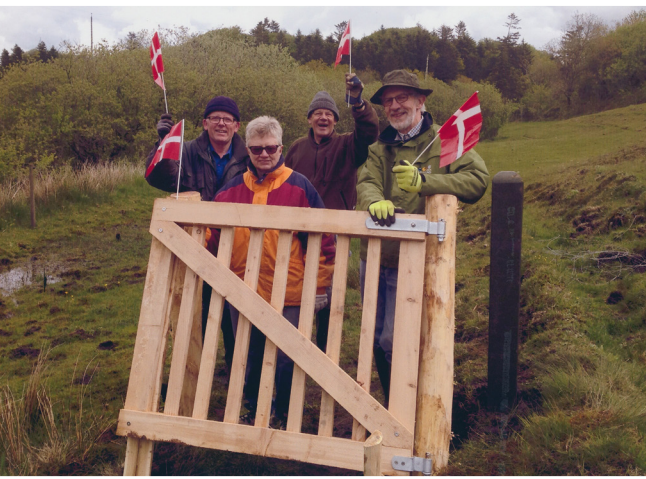
Færdigt arbejde med ny klaplåge
